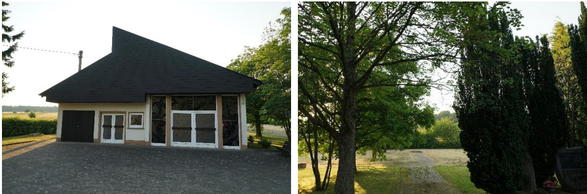
Trauerhalle (links) und rückwärtig liegende, ungenutzte Fläche (rechts), auf dem Friedhof Stahlhofen
