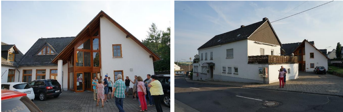
Dorfgemeinschaftshaus (links) und ehemalige Gastwirtschaft (rechts) in Stahlhofen
